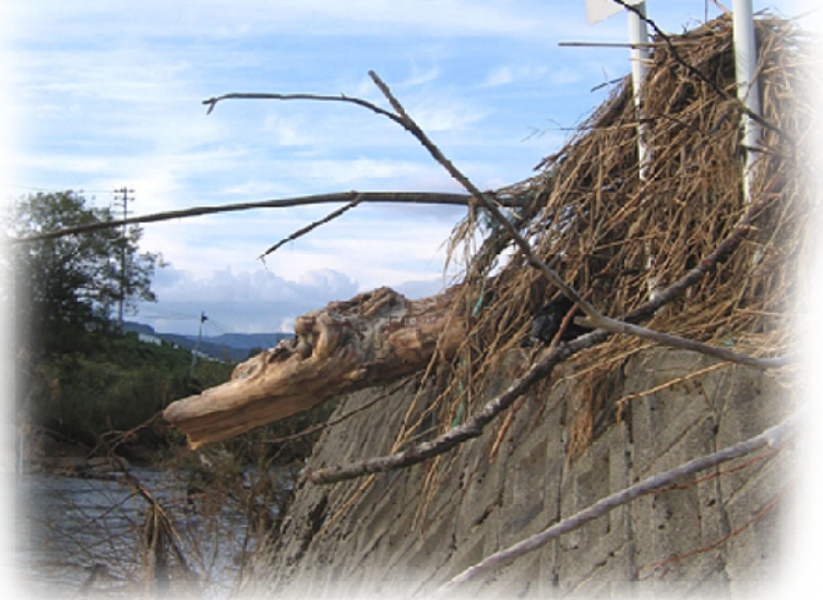
大雨の爪痕が残る松木内川(西木町上松木内地区)
